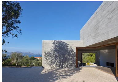
Située sur la plus haute des restanques, la maison s'organise autour d'une « place », un espace extérieur fédérateur, à l'ombre d'un olivier avec vue sur la mer.
