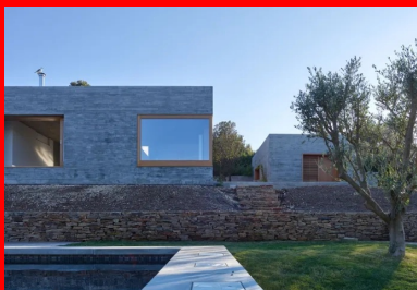
Les parements se placent en retrait du mur pour mettre en scène l'épaisseur du matériau et créer des jeux d'ombre et de lumière, seule exception à la règle, la fenêtre d'angle implantée au nu extérieur pour créer une assise dans le salon.
