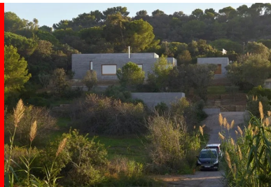
Les différents volumes en béton à la planche composent la maison s'intégrant harmonieusement dans le grand paysage.
