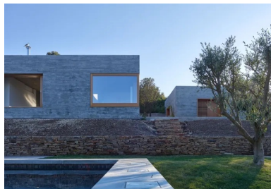
Les percements se placent en retrait du mur pour mettre en scène l'épaisseur du matériau et créer des jeux d'ombre et de lumière, seule exception à la règle, la fenêtre d'angle implantée au nu extérieur pour créer une assise dans le salon.
