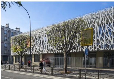
Une résille à la thématique végétale, composée d'éléments préfabriqués en béton blanc fibré à ultra hautes performances (bfup), habille et protège les façades sur rue.
