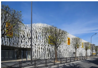
L'entrée de l'école s'organise sous l'encorbellement du 1 er étage rue Charles Fourier.
