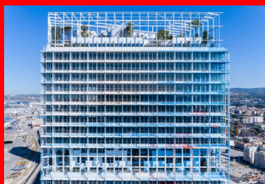
Façade sud. Par leur prolongement sur les faux plafonds, les couleurs des brise-soleil estompent la limite entre intérieur et extérieur.
