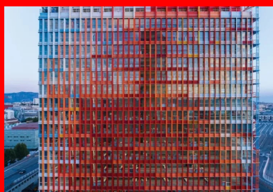
Façade nord. Les menuiseries en aluminium qui encadrent le vitrage disparaissent dans l'alliage en Bflup, accentuant l'effet de transparence.
