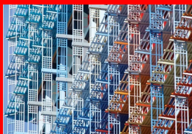
Tout en dentelle et couleurs, la grille en Bflup des façades sud et ouest semble particulièrement légère.
