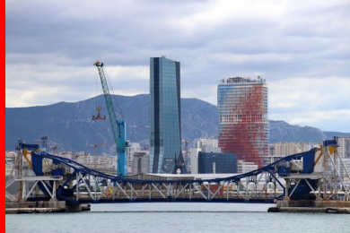
Depuis la mer, la façade nord rougeoyante de la Marseillaise émerge à côté de la tour CGM : symboles d'un renouveau économique annoncé.
