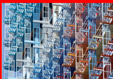
Tout en dentelle et cailloux, la grille en Btup des façades sud et ouest semble particulièrement légère.
