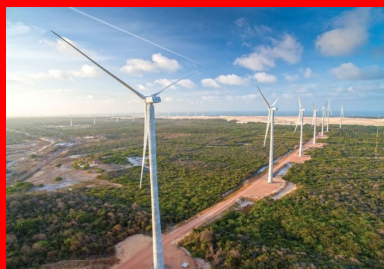
Vue générale de la ferme pilote de Trairi, au nord-est du Brésil. Les 36 éoliennes, dont les tours culminent à 119 m, développent une puissance unitaire de 2,7 MW.
