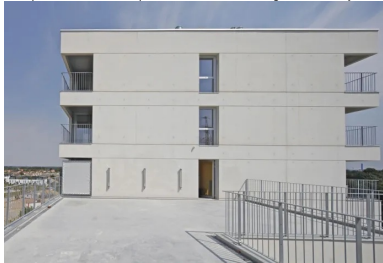
Dans les étages, les plateformes extérieures offrent près de 1 700 m 2 d'espaces collectifs à partager.
