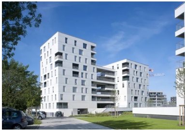
De grandes terrasses collectives relient et distribuent les plots.
