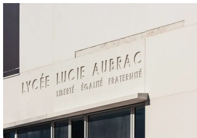
Détail d'un insert de béton matricé et de la signalétique incrustés dans le béton poli.
