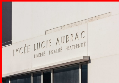
Détail d'un insert de béton matricé et de la signalétique incrustés dans le béton poli.
