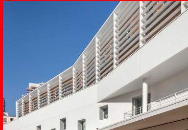
Vue de la façade ouest.
