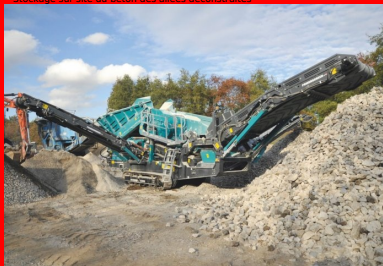
Concassage du béton sur le site
