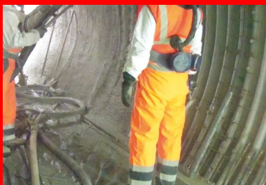
Projection de BFUP au cours du chantier expérimental.
