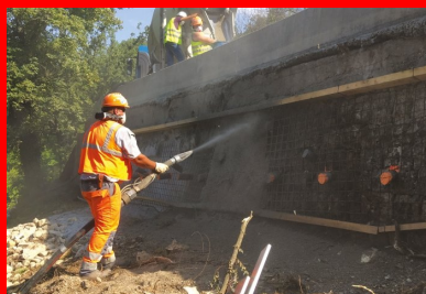
Réparation d'un parement par projection par voie sèche.
