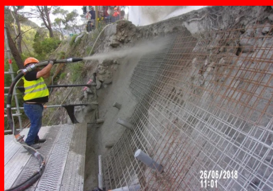
Confortement de talus par voie sèche.
