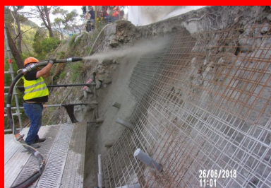
Confortement de talus par voie sèche.
