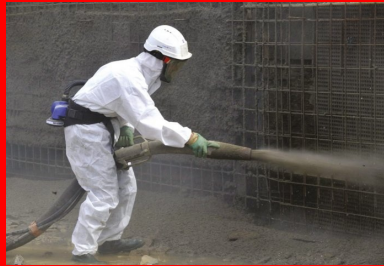
Opérateur de projection en voie mouillée
