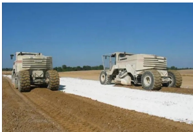
Traitement des sols - Un malaxeur mélange le liant hydraulique routier avec le sol
