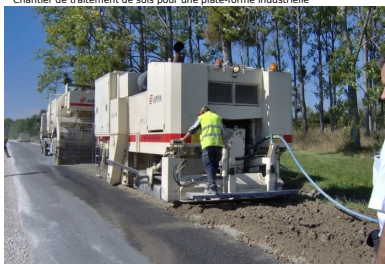
Vue générale d'un chantier de retraitement d'une chaussée en place avec un liant hydraulique routier
