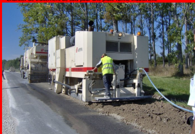
Vue générale d'un chantier de retraitement d'une chaussée en place avec un liant hydraulique routier
