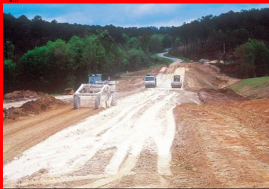
Chantier de traitement de sols en terrassement routier
