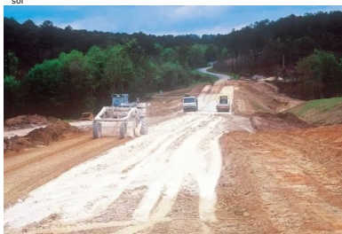
Chantier de traitement de sols en terrassements routiers
