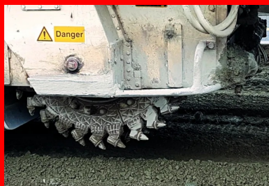
En plus de son rotor de 2 m de largeur avec 224 dents, l'ARC 1000® est équipé d'une lame flottante pour assurer le nivellement du fond de forme, d'un malaxeur, d'une vis
