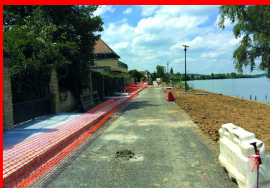
Avant. L'ancien chemin au début des travaux.
