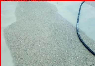
Quarante-huit heures après la mise en œuvre, un atelier d'hydrosablage par voie humide est intervenu pour retirer la peau du béton et faire apparaître les granulats.
