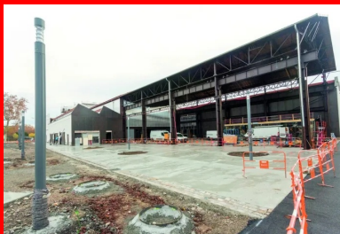
La première mise en œuvre du béton 100 % à base de granulats recyclés a été réalisée par Sols Confluence sur les abords de la nouvelle halle Girard, alias H7-Lyon French Tech. Elle a eu lieu à partir du 14 novembre 2018, en cinq jours de coulage, à raison de 20 à 30 m 3 quotidiens pour une équipe de 3 à 5 personnes, « directement à la troupe et au dumper. »
