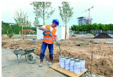
Préparation des tests de performances mécaniques et de tenue dans le temps
