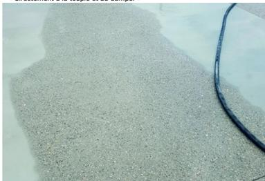
Quarante-huit heures après la mise en œuvre, un atelier d'hydrosablage par voie humide est intervenu pour retirer la peau du béton et faire apparaître les granulats
