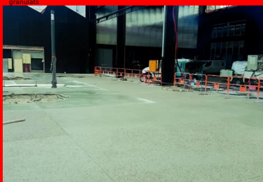
Le nouveau revêtement à une « apparence assez brute, de couleur grise, avec des agrégats roulés visibles, allant de l'ocre au noir. Il assure un bon confort de marche et une bonne adhérence. »
