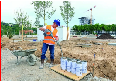
Préparation des tests de performances mécaniques et de tenue dans le temps
