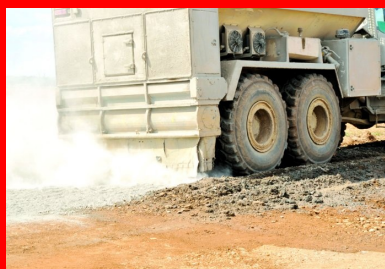
Epannage du liant hydraulique routier Rolac® Premier 635 de LafargeHolcim sur le fraiisat de l'ancienne chaussée préalablement défragmentée.
