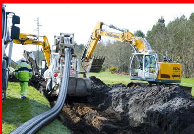
Disposés en tréfile au fond de la tranchée, les câbles sont recouverts de remblai liquide, puis la tranchée est comblée avec la terre excavée. Un grillage de plastique rouge inséré dans la tranchée signale la présence de la ligne haute tension.
