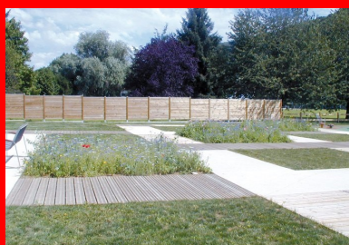
En bordure de route et du Doubs, le square de Velotte (2 800 m 2 ) compte deux aires de jeux pour enfants, ses cheminements réalisés en béton décoratif Articimo® (Holcim Bétons) micro-désactivé de ton pierre s'harmonisent parfaitement avec les autres matériaux utilisés : le bois (pour le platelage) et la pierre (pour le pavage).
