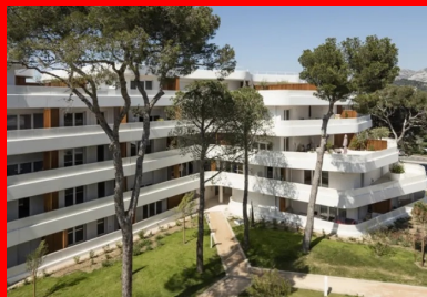
L'aménagement paysager de l'intérieur de l'îlot associe les pins qui ont été préservés à de nouvelles plantations d'espèces endogènes.
