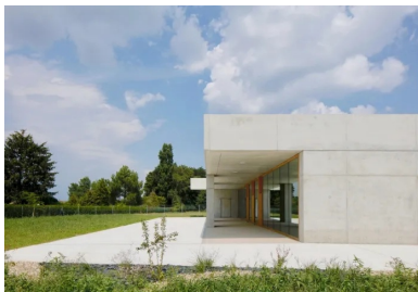
Le volume se creuse pour aménager des lieux de vie extérieurs protégés du soleil et des intempéries par les avancées de toiture.
