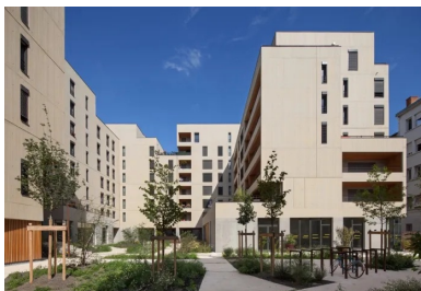
Au cœur de l'opération, un jardin dessert les halls d'accès et les locaux annexes.
