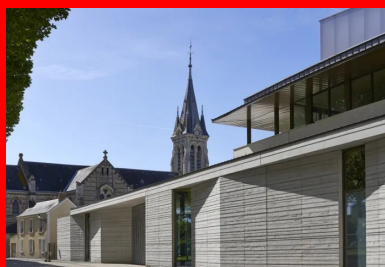
Aux côtés de l'église, le béton instaure un dialogue des matières avec l'existant.
