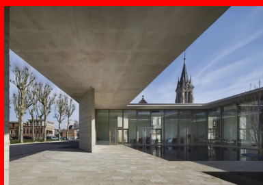
Les débords de toiture et la présence du miroir d'eau soulignent la géométrie d'une architecture où les vides et les effets de filtre sont une composante essentielle.
