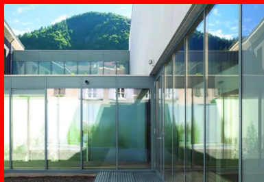
Un patio intérieur planté sépare le bâtiment existant de la nouvelle extension.
