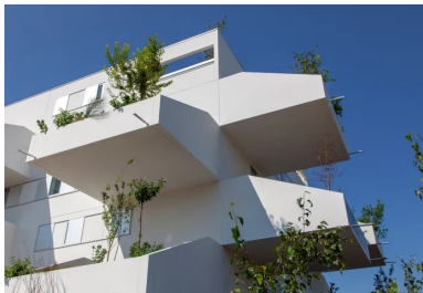
Les logements sont disposés sur un système tournant, ce qui dilate la hauteur des balcons.
