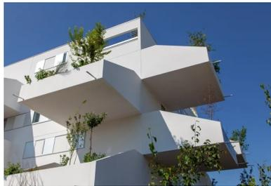
Les logements sont disposés sur un système tournant, ce qui dilate la hauteur des balcons.
