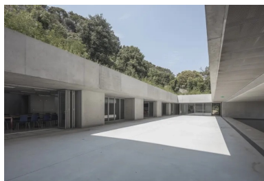
autour du patio, les salles communes possèdent des baies totalement escamotables pour gommer la limite entre l'intérieur et l'extérieur.
