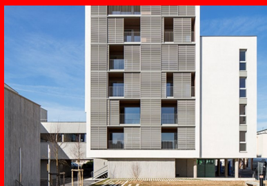
Les volets persiennés couvrants des loggias protègent du soleil et des vues.
