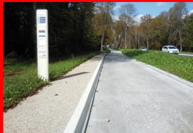
La chaussée béton est constituée d'une dalle béton de 3,5 m de largeur et de 20 cm d'épaisseur, avec caniveau intégré ainsi que des bordures longitudinales.
