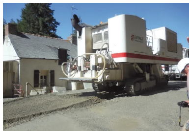
Vue de l'arrière de l'ARC 1000 d'Eiffage. Cette véritable « centrale mobile » décohésionne l'ancienne chaussée « transversalement et verticalement », mélange le liant avec le matériau en place avant l'homogénéisation de l'ensemble des constituants à l'aide d'un malaxeur intégré.
