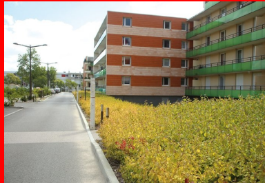
Parmi le nouveau mobilier urbain du quartier, des totems en béton blanc (préfabriqué sur mesure) marquent l'entrée de chaque immeuble
