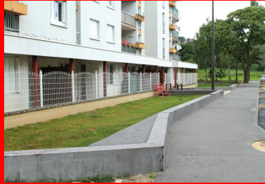
Le quartier maison Rouge dispose désormais de trottoirs en béton chocolat sablé avec liseré lisse. Les murets également en béton chocolat ont, quant à eux, une finition brossée
