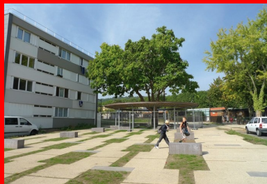
Des banquettes en béton chocolat ponctuent cet espace réalisé avec des dalles en béton coulées en place, tan pierre avec carbure de silicium désactivé, et des joints en gazon
