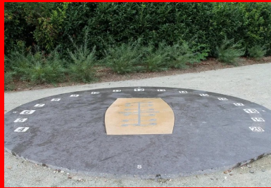
Ce cadran solaire analemattique a été réalisé en béton chocolat et ton pierre avec des incrustations de sérigraphies métalliques.
