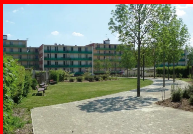
La rénovation du quartier maison Rouge a consisté à lui donner une unité, notamment grâce à des espaces verts de transition, au premier plan, une allée en sable stabilisé d'authèvesmes (27) renforcé avec 5 % de ciment.
