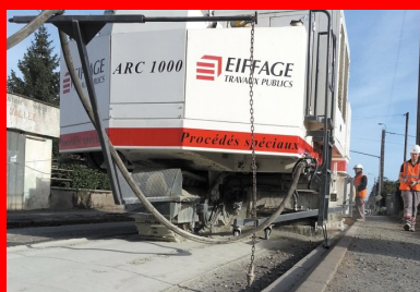
L'ARC® 1000 vu de face, avec sa chenille avant qui précède le rotor de 2 mètres de largeur doté de 224 dents.
