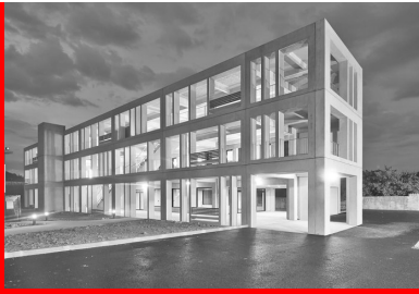
Bâtiment Aziyadé - 92 logements étudiants à La Roche-sur-Foron, (MOA : CROUS de Poitiers)
