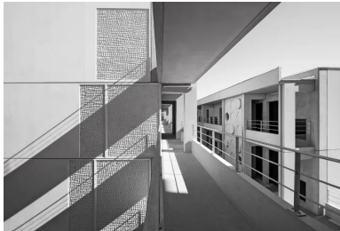
Bâtiment Azyadé - 92 logements étudiants à La Rochelle. (MOA : CROUS de Poitiers)
