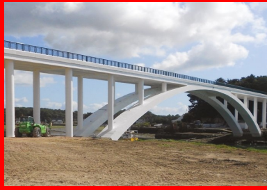
Pont Kerisper après travaux
