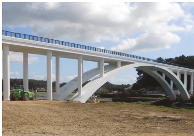
Pont Kerisper après travaux
