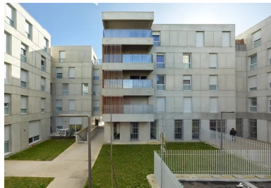
Le calepinage soigné et rigoureux des joints creux, des nez de balcon et des fenêtres rythme les façades.
