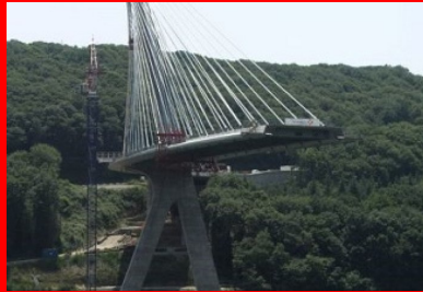
Construction du pont à haubans de Térénez (29), inauguré en 2011. Pylône en lambda renversé. (c) photo Noël Richet
