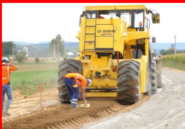
Derrière le malaxeur Bomag RS 650, un technicien vérifie visuellement l'homogénéité du mélange entre le matériau de l'ancienne chaussée et le liant hydraulique, et un autre mesure la teneur en eau du matériau traité.
