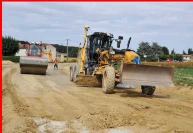
Dernière le malaxeur, la mise en œuvre se poursuit avec le nivellement de la chaussée (à droite) et le compactage du matériau (à gauche).
