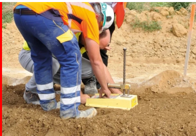
Vérification de l'humidification et de la densité réalisée à l'aide d'une jauge Humboldt HS-5001EZ.
