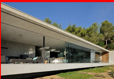
Le volume inférieur prend la forme d'un parallélépipède rectangle allongé en béton brut, dont la longue façade entièrement vitrée offre une vue panoramique sur la mer.
