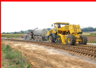
Derrière le malaxeur Bomag R5 650, un technicien vérifie visuellement l'homogénéité du mélange entre le matériau de l'ancienne chaussée et le liant hydraulique.
