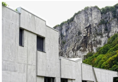
La façade sur rue est animée par un jeu de plans décalés qui rappellent les anfractuosités d'une roche.
