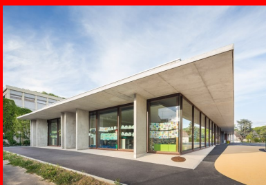
L'auvent de la façade ouest repose en partie sur des voiles béton verticaux qui complètent le dispositif brise-soleil.
