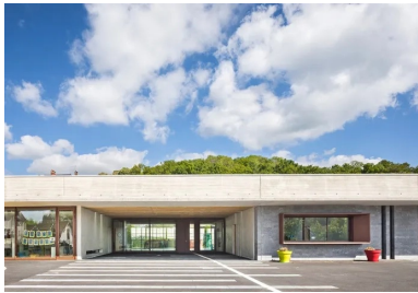
En transparence avec la salle de motricité au niveau du préau et du hall, le bâtiment semble transpercé par la lumière.
