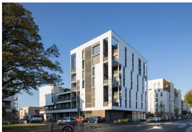
Le volume cubique vertical de l'immeuble plot participe au front bâti de la rue Daniel-Meyer.
