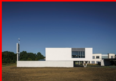
Le projet se compose de deux volumes qui jouent sur des glissements de l'un par rapport à l'autre.
