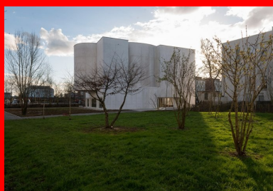
La hauteur de l'église s'accorde à celle des bâtiments alentour.
