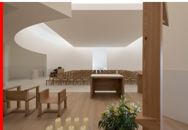
La courbe de l'église est marquée en hauteur par une poutre en béton suspendue qui assure le report des charges sur les descentes verticales.
