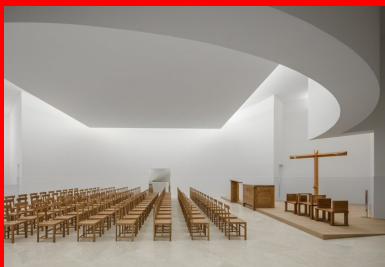
Le panneau carré surplombe la partie centrale de l'église. Il diffuse la lumière zénithale de la verrière située au-dessus.
