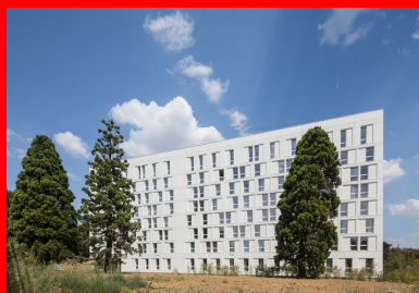
La façade ouest, plus fermée car exposée aux nuisances et composée de panneaux de béton blanc dépolissant.
