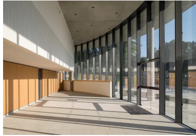
Le plafond du hall principal, façon faux plafond en béton gris autoplaçant, « suspendu » à la dalle porteuse des étages supérieurs.
