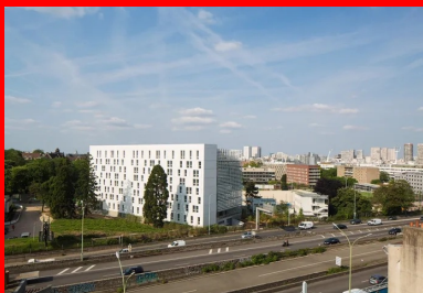
Les façades sud et ouest en lien direct avec les flux de voitures circulant sur le boulevard périphérique.
