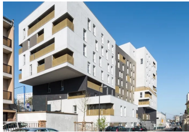
Au sud, un porte-à-faux assure la transition avec le bâtiment voisin.
