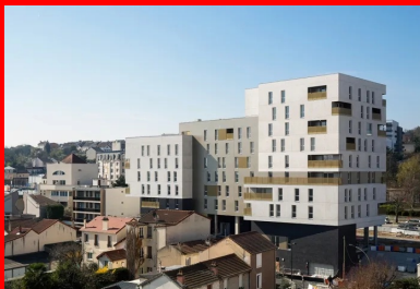
Découpée en trois parties, l'opération s'élève progressivement de R+5 à R+8.
