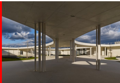
La couverture partielle de la cour crée des cadres vers le ciel.
