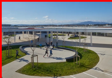
Le système en cour de cloître forme une protection contre les vents fréquents.
