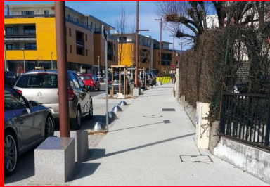
Les travaux se sont concentrés sur une zone de 400 m de long située sur la rue commerciale du bourg.
