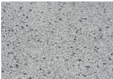
(En médaillon) Des granulats provenant de la carrière savoyarde de Grésy-sur-Aix ont été utilisés avec un mélange de basalte.
