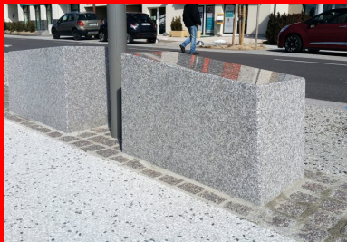
Le mélange de granulats Grésy avec une incorporation de basalte noir apporte un effet moucheté en surface, qui s'harmonise bien avec le granit, en créant un ensemble homogène.
