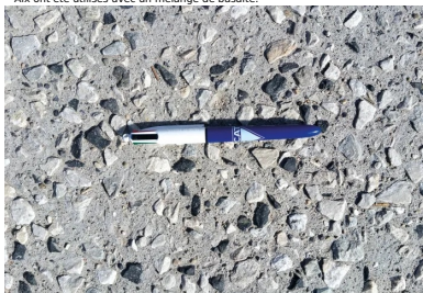
Le granulats 8/20 utilisé pour les places de stationnement s'incorpore aisément dans le béton et résiste bien à l'arrachement.
