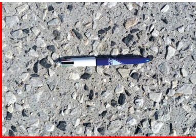
Le granulats B/20 utilisé pour les places de stationnement s'incorpore aisément dans le béton et résiste bien à l'arrachement.
