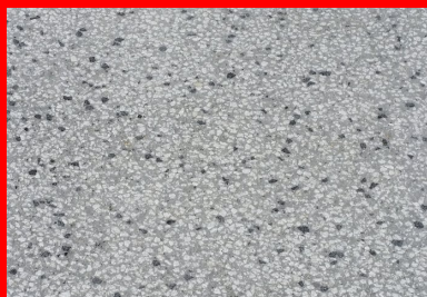
(En médaillon) Des granulats provenant de la carrière savoyarde de Grésy-sur-Aix ont été utilisés avec un mélange de basalte.
