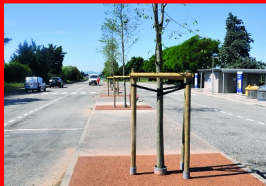
Un réaménagement réussi. Le béton drainant participe tout à la fois à la rénovation de l'aire d'autoroute, à l'amélioration du confort des usagers et à un meilleur respect de l'environnement.
