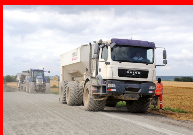
Épandage du liant hydraulique routier LVTS 54 de Vicat et vérification de la bonne répartition du liant au mètre carré (méthode dite « à la bêche »).
