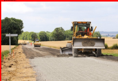
Passage de la niveleuse pour un bon uni et le meilleur profil géométrique possible.
