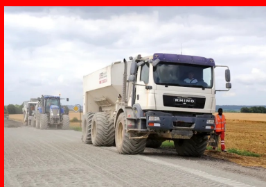
Epandage du liant hydraulique routier LVT5 54 de Vicat et vérification de la bonne répartition du liant au mètre carré (méthode dite « à la bêche »).
