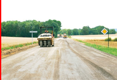
L'atelier de compactage composé d'un « vibrant » (un cylindre monorouleau V5) et d'un « pneu » (un PS 300).
