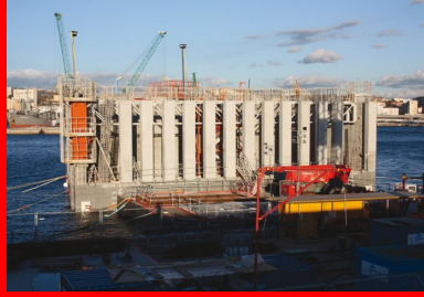
Afin d'éclaircir la teinte des poteaux Jarlan en béton qui resteront visibles en phase définitive, leur formulation intègre du dioxyde de titane.
