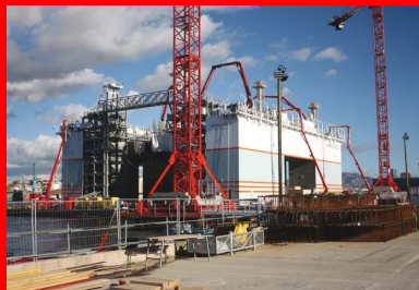
Le bétonnage continu des caissons est réalisé par l'intermédiaire de trois mâts de bétonnage, reliés sur le quai à trois pompes à béton, alimentées par des camions toupies béton.
