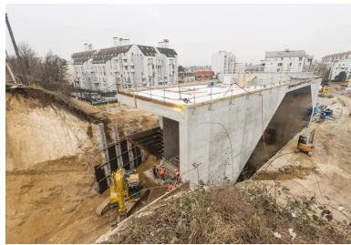
Ripage du pont-rail à Champigny.
