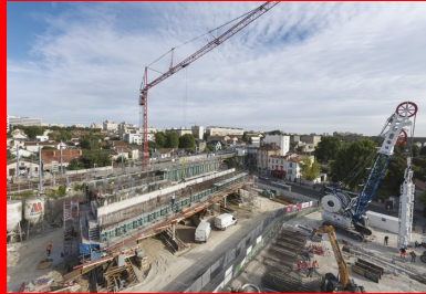
Réalisation du pont-dalle.
