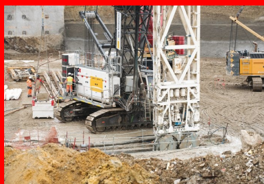
Chantier des parois moulées à Villejuif Institut Gustave Roussy.
