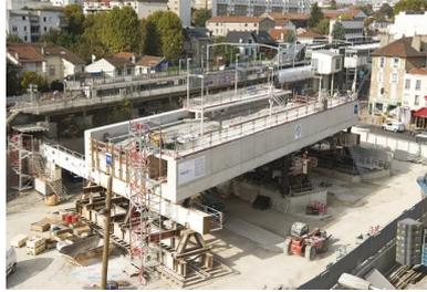
Avancée du chantier à Arcueil - Cachan avec mise en place du pont-dalle.
