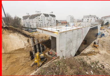
Ripage du pont-rail à Champigny.
