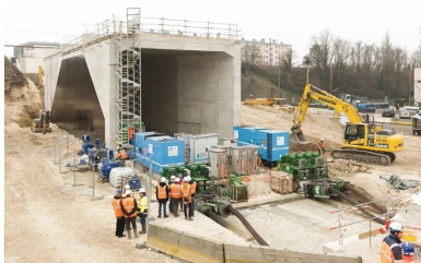
Ripage du pont-rail à Champigny.
