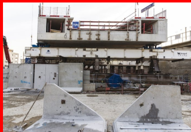
Début de l'opération de ripage du pont-dalle.
