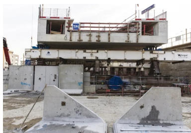
Début de l'opération de ripage du pont-dalle.
