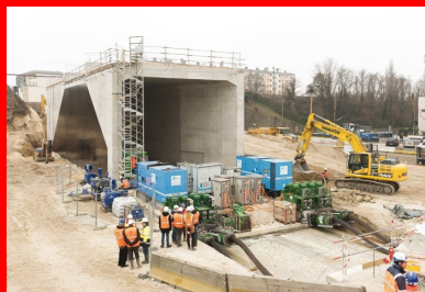
Ripage du pont-rail à Champigny.
